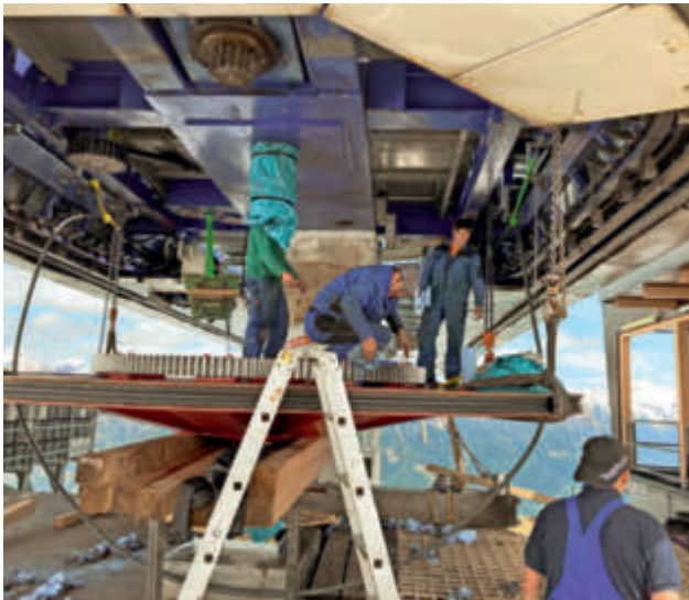
Erneuerung der Seilbahntechnik bei der 4er-Sesselbahn Sendleiten . Erneuert wurden dabei speziell jene Baugruppen, für die keine Ersatzteile mehr verfügbar waren oder die an der Verschleißgrenze lagen.
