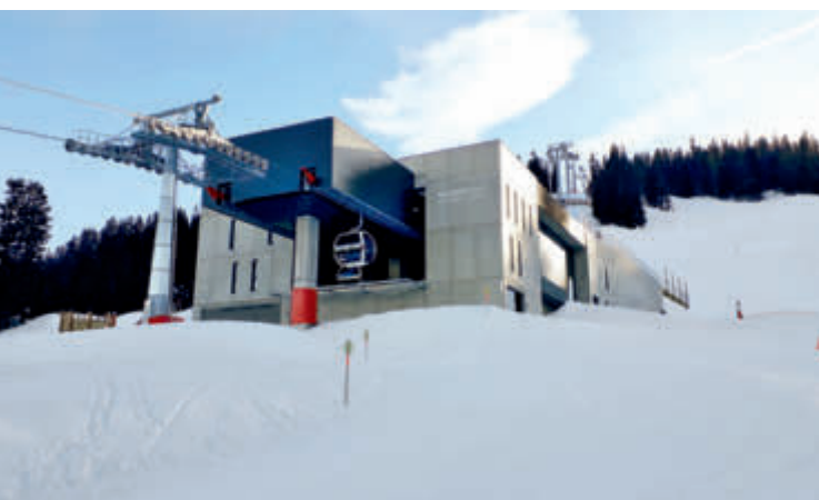
Die Mittelstation der neuen Valisera-Bahn fügt sich harmonisch in das Landschaftsbild ein. Skifahrer können sie von beiden Seiten gleich gut erreichen.
