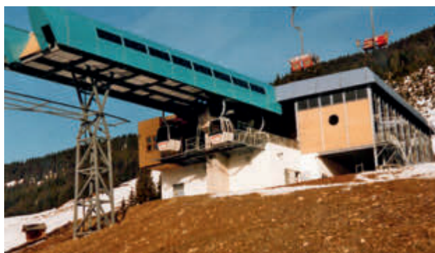
Das erste selbsttragendes Stationsgerüst Österreichs bei der Bergstation der 12er-EUB Schönleitenbahn , Saalbach.
