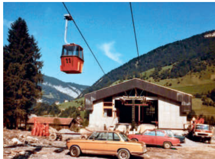
Die 4er-EUB Rossstelle im Skigebiet Mellau war die erste kuppelbare Kabinen-Einseilumlaufbahn in Österreich.
