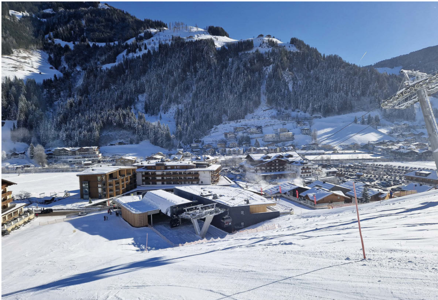
Die neue Talstation der Kieserlbahn in Großarl spielt alle Stückerl: barrierefreier Zugang, Tiefgarage, Büros, Sportshop, Skidepot, Dienstwohnungen und Restaurant.
