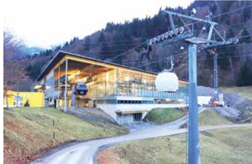
In der Zwischenstation Latschau werden eine neue Pistengerätegarage (rechts) und ein neuer Müllraum (unten vorne) realisiert.
