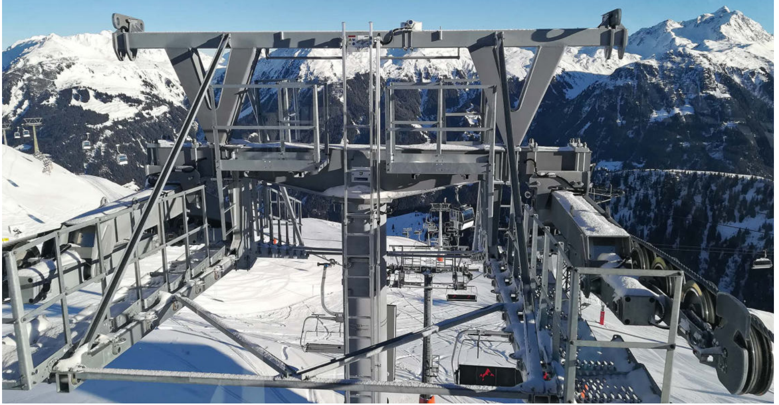
Wesentliche Teile der gebrauchten Anlage konnten im Montafon weiterverwendet werden.
