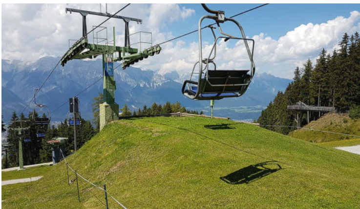
Retro, romantisch und verlustreich: die Glungezerbahn vor der Erneuerung.
