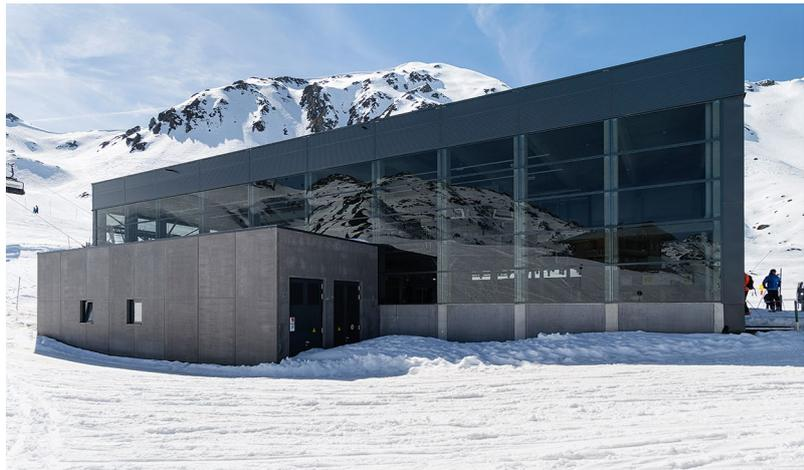
Die Garagierung der Sessel erfolgt in einem seitlich angeordneten Schleifenbahnhof. Die Halle ist eine Konstruktion aus Beton-Fertigteilen.
