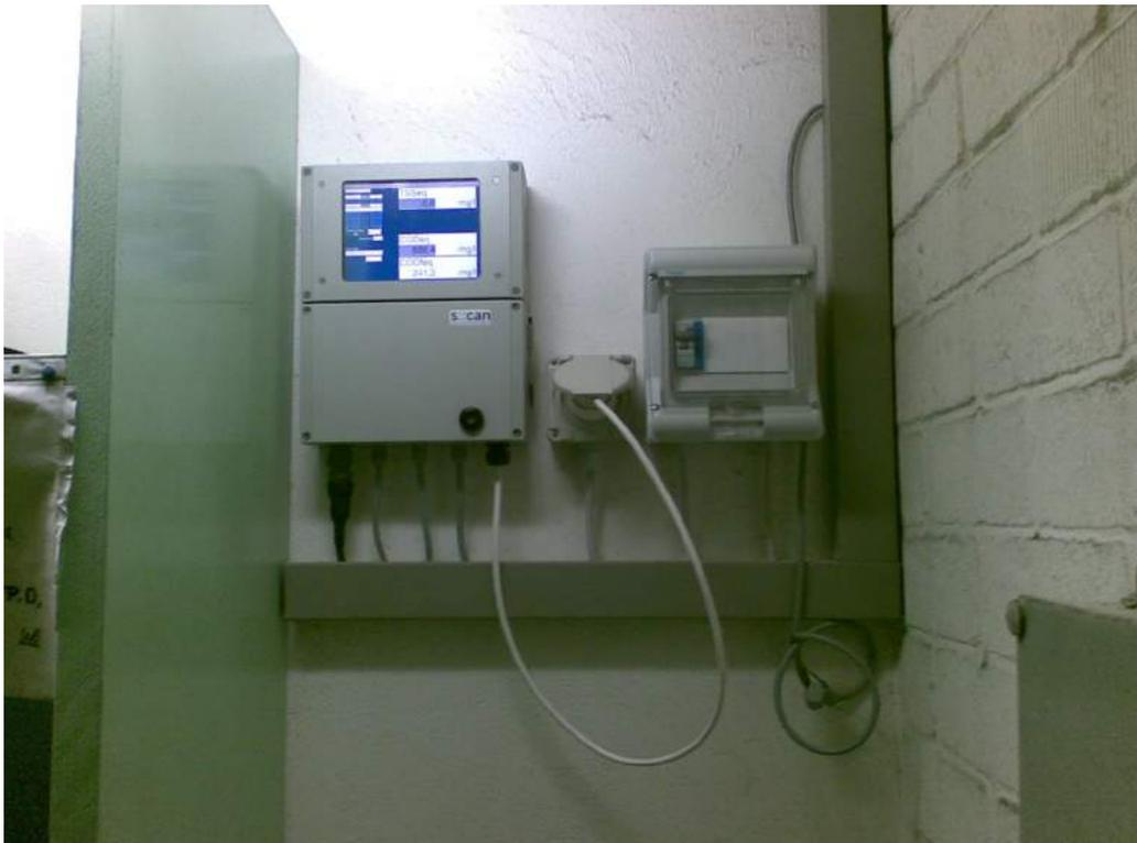
Abbildung 3: Steuergerät Messsonde
