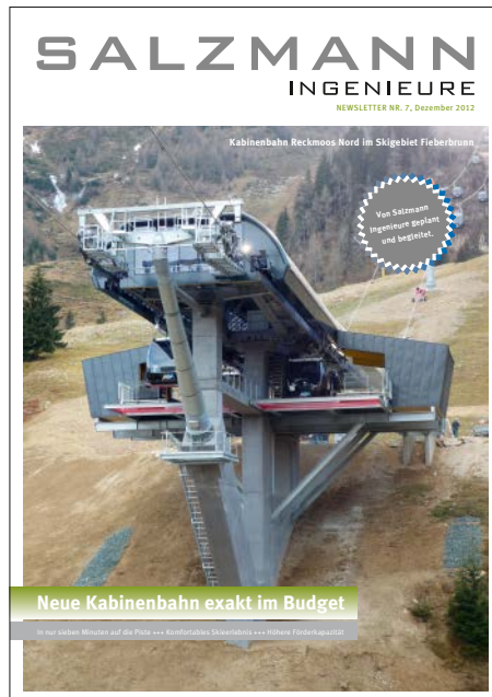
Kabinenbahn Reckmoos Nord, Fieberbrunn, Tirol
