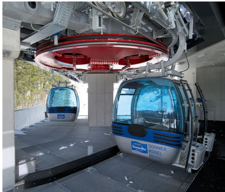
In der Mittelstation treibt das untere Seil die obere Seilschleife über eine zweirillige Scheibe an. Diese Lösung ist seilbahntechnisch interessant und kostengünstig.
